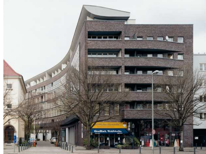
23) Wohnbebauung am Luisenplatz, 1987
